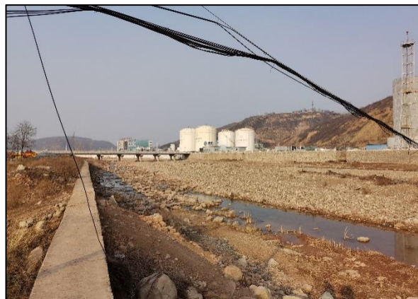
金峰村村口拟穿越固县河处
