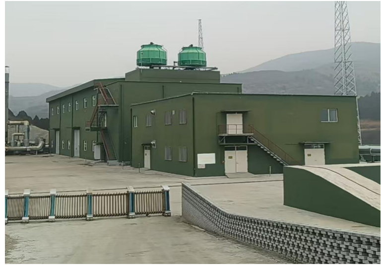
主机室、管道间及水泵间
