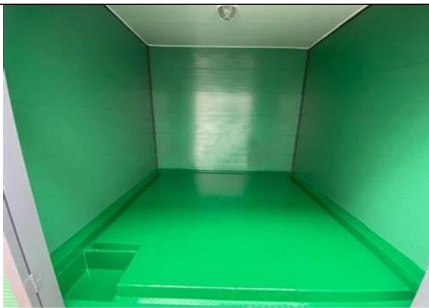
图 5.3 集装箱危废贮存点内部防渗示意图
