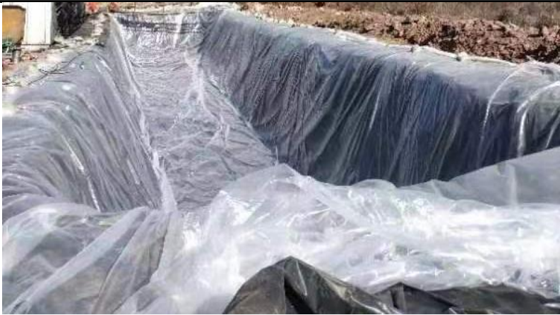
图 5.1 泥浆池、采排水池防渗示意图
