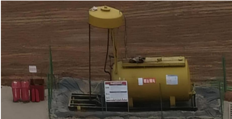
图 5.2 柴油罐区防渗示意图
