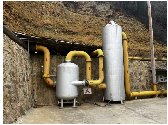
现有工程水气分离装置
