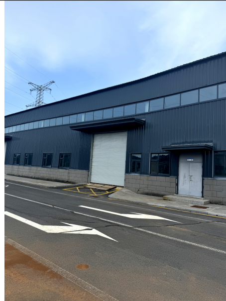
沁水县第三自来水厂拟拆除库房
