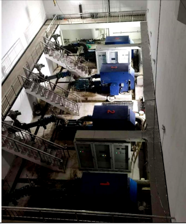
张峰水库一泵站泵房现状
