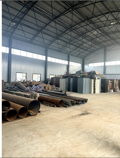
沁水县第三自来水厂拟拆除库房内部2
