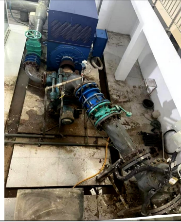
张峰水库一泵站泵房设备现状
