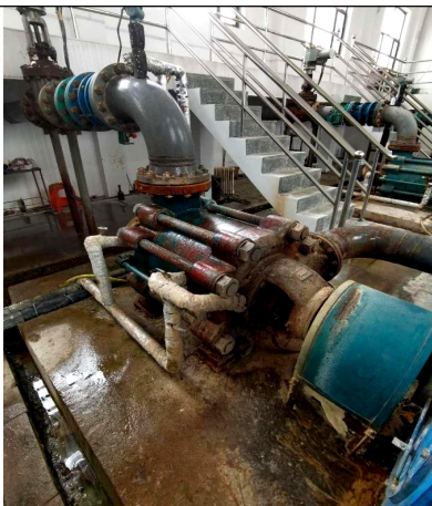
张峰水库二泵站泵房现状
